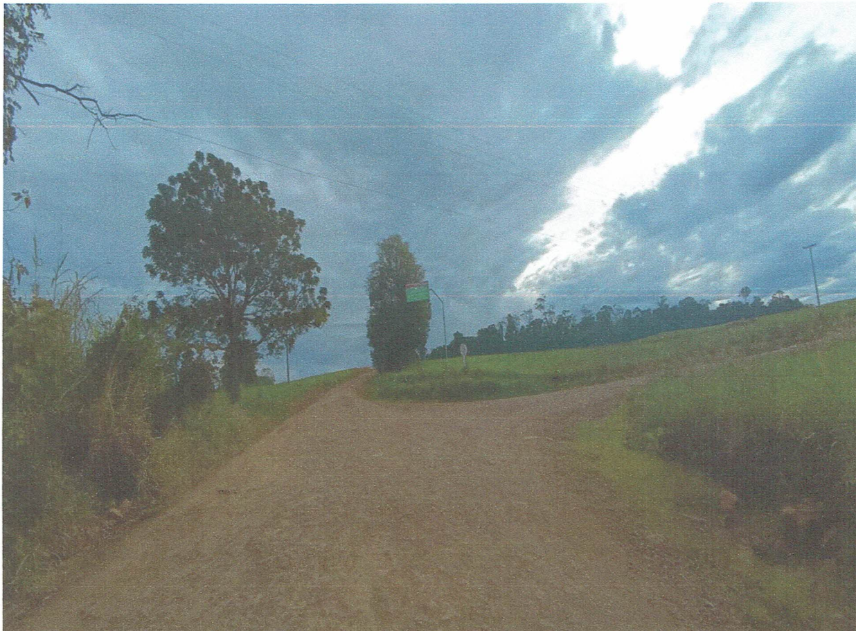
Foto 3.: Final do trecho a ser pavimentada no Acesso a Linha Tunas em CBUQ.
