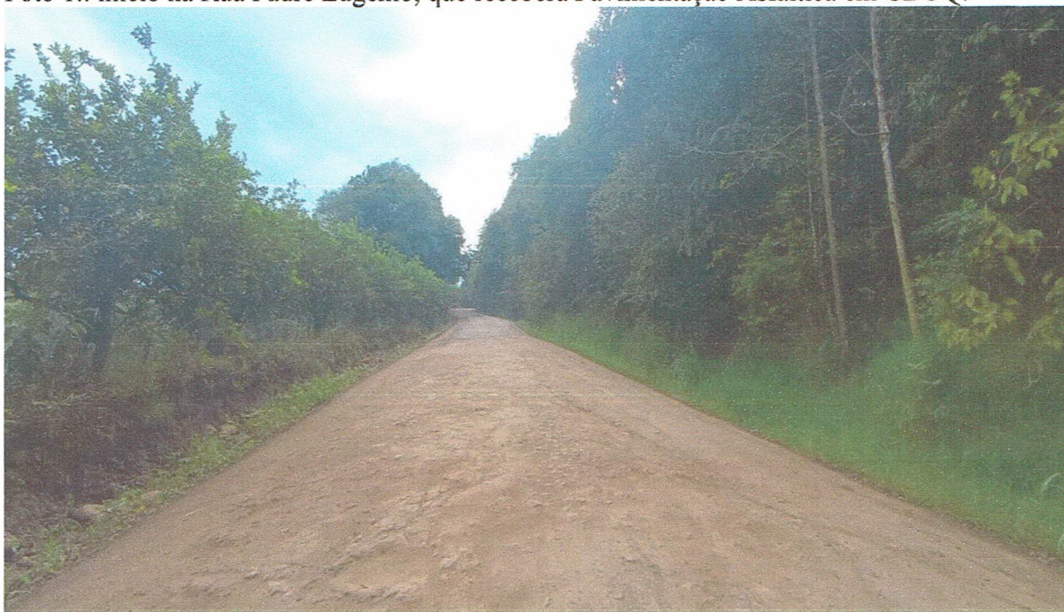
Foto 2.: trecho da estrada ERS 143 a ser pavimentada em CBUQ.
